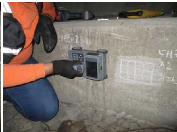
철근 피복두께 측정
