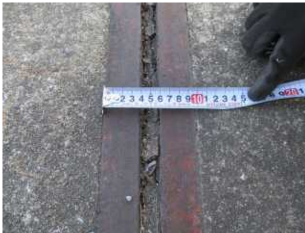
신축이음 유간거리 측정
