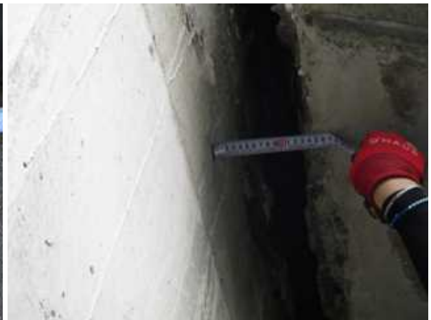
신축이음 유간거리 측정
